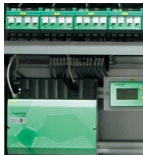
Automationsstationen EY3600 mit lokaler Bedienung EYT240 und Feldmodule.
